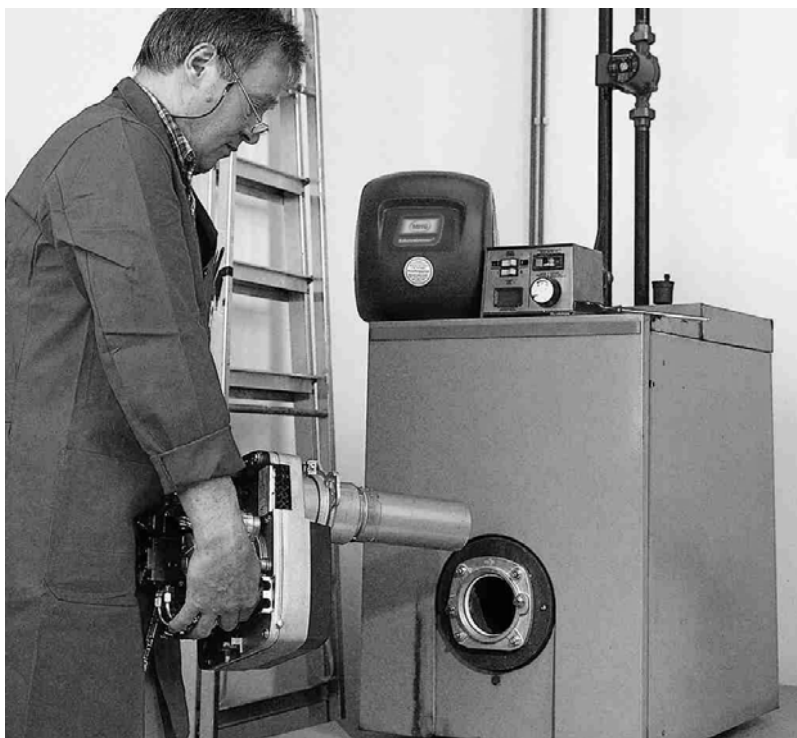
σχ. 10: Τοποθέτηση καυστήρα-λέβητα I
