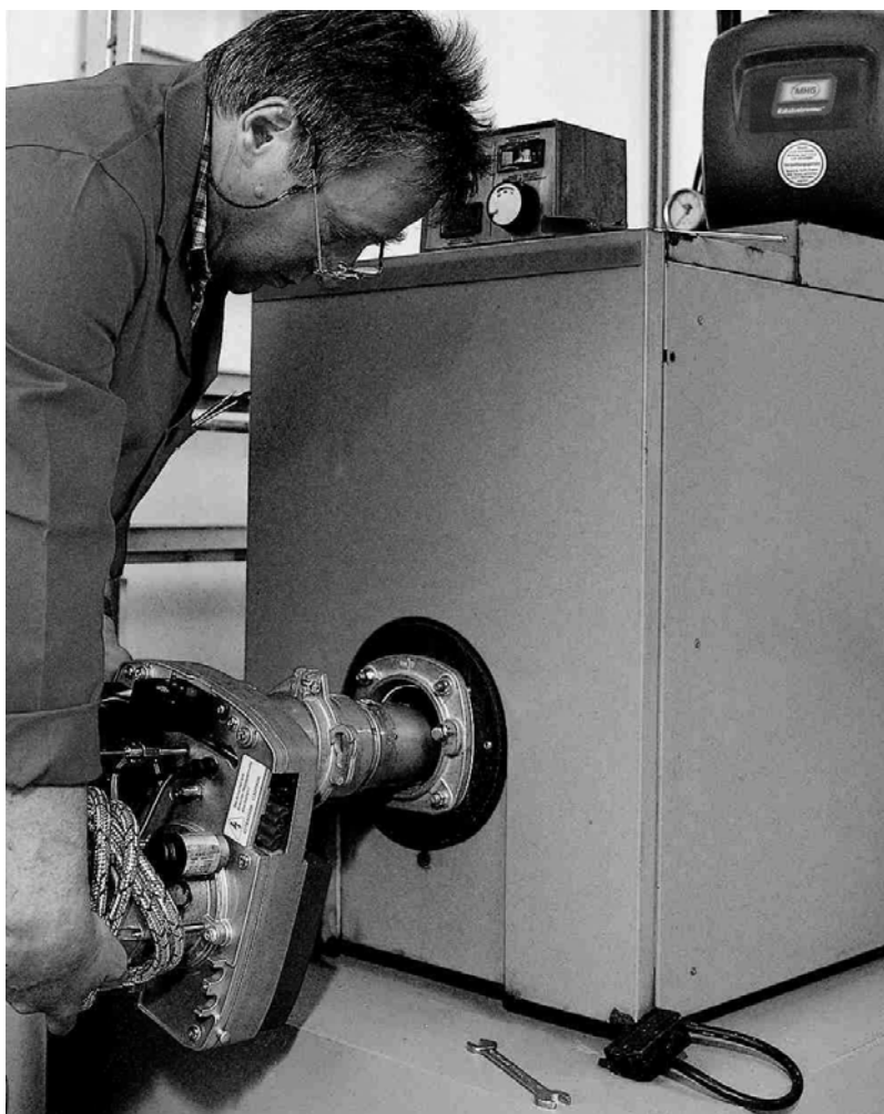
σχ. 11: Τοποθέτηση καυστήρα-λέβητα II
