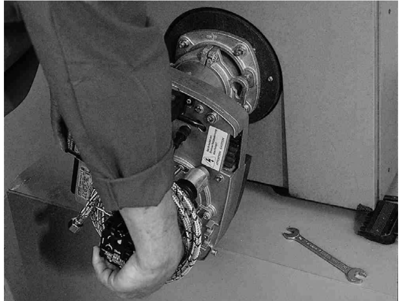
σχ. 12: Τοποθέτηση καυστήρα-λέβητα III
