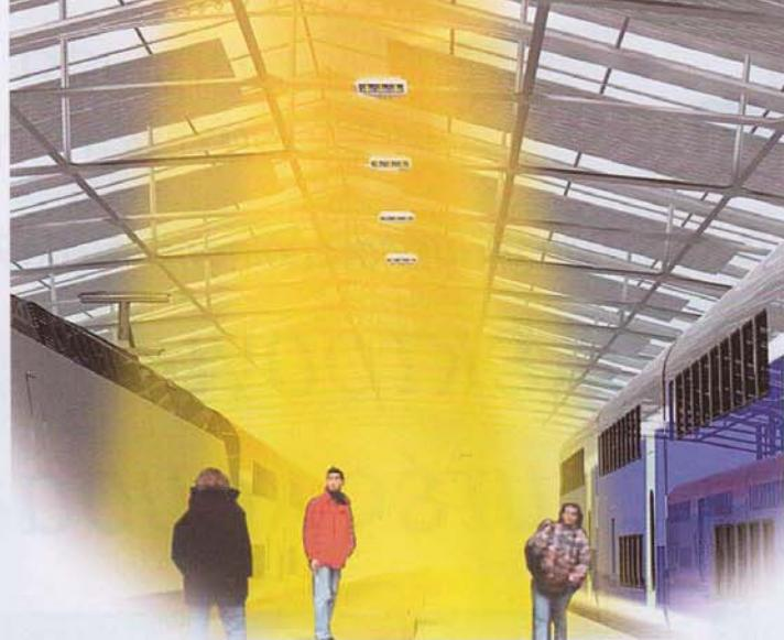
λεκτρικές συσκευές τοπικής θέρμανσης. Αποτελούνται από ένα θερμαντικό στοιχείο (ηλεκτρική αντίσταση), ένα δργανο ελέγχου (μηχανικό ή ηλεκτρονικό θερμοστάτη) και ένα μεταλλικό περίβλημα, που αποτελεί το σώμα του θερμοπομπού.
